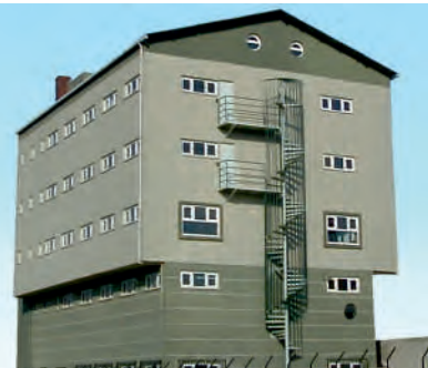
Eleksan - İstanbul tesisleri
